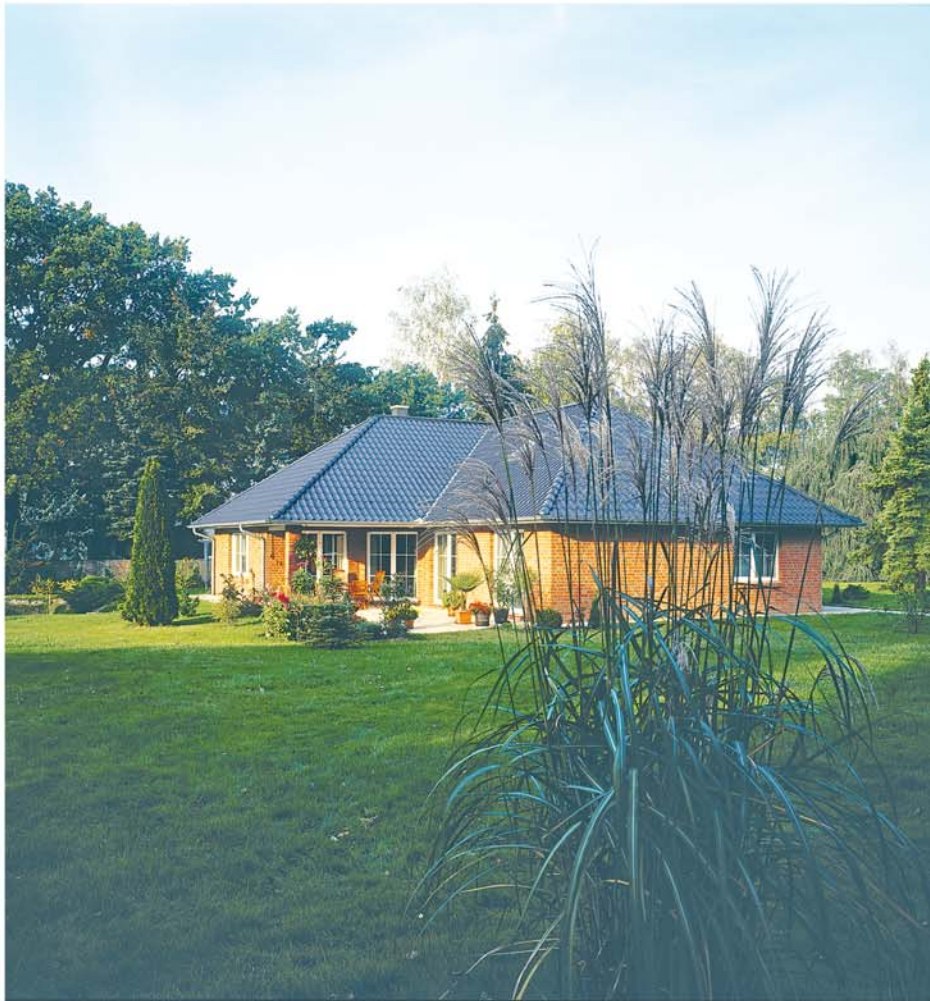
Ein Bungalow B 300 der Bauunion 1905. Ein Winkelbungalow schafft immer einen wunderbaren Platz für eine geschützte Terrasse.
